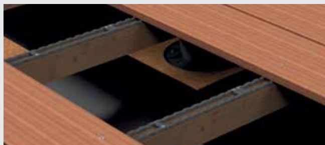
L'utilisation du Liteau d'écartement 2.0 permet d'éviter le cisaillement des vis.
